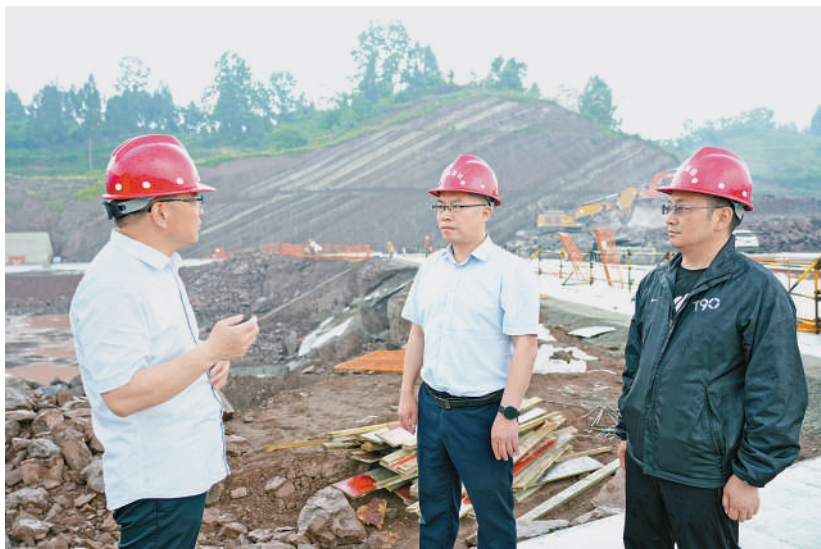
宣汉县纪委监委督导组实地察看西渝高铁宣汉南站项目建设进度。(杨涛 摄)
